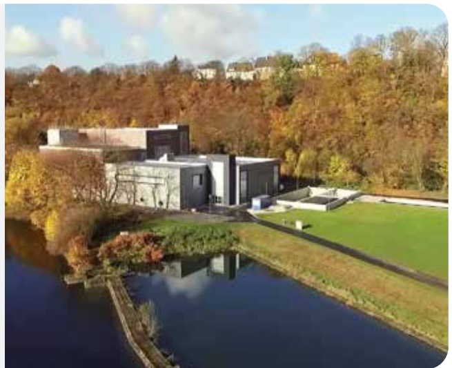
WITTEN (Inbetriebnahme WAA 04/2018)
