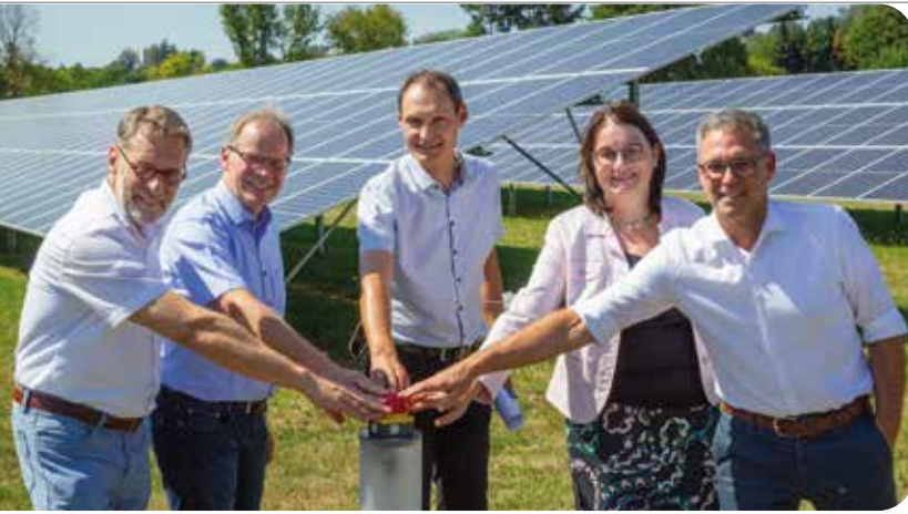
(v. l.): Dr. Bernhard Klocke (GF WWW), Dr. Martin Michalzik (Bürgermeister in Wickede Ruhr), Bernd Heinz (GF WWW), Birgit Dalhoff (Kreis Soest) und Dr. Dirk Grete (Bezirksregierung Arnsberg) bei der Inbetriebnahme der neuen PV-Freiflächenanlage im Wasserwerk Echthausen.
