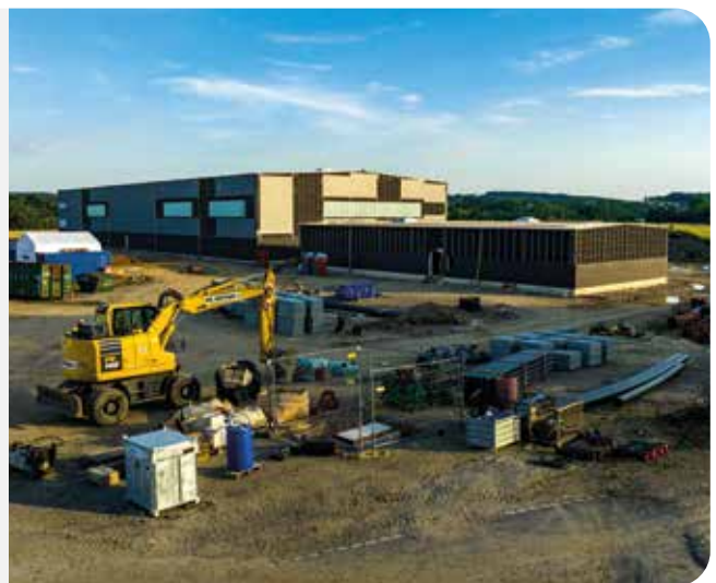
HALINGEN (Baubeginn WAA 09/2021)
