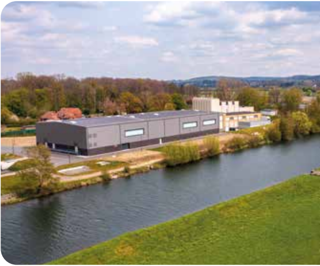
WESTHOFEN (Inbetriebnahme WAA 05/2021)
